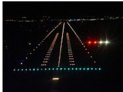
Figura 14. Luces de zona de toma de contacto. Iluminan los primeros 3000 ft de pista para operaciones con RVR inferior a 2400 ft.
